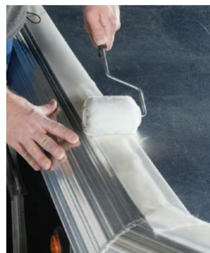
**3.** Con un rodillo manual blando, aplique presión para que la cinta se conforme a los contornos, grietas o tornillería de la superficie.
