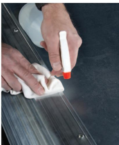
**1.** Limpiar con mezcla de agua y alcohol isopropílico con un trapo seco\*
